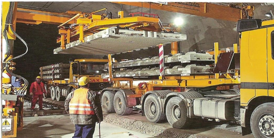
Рисунок 4.10 – Разгрузка стрелочного перевода на бетонных плитах заводского изготовления с грузового автомобиля
