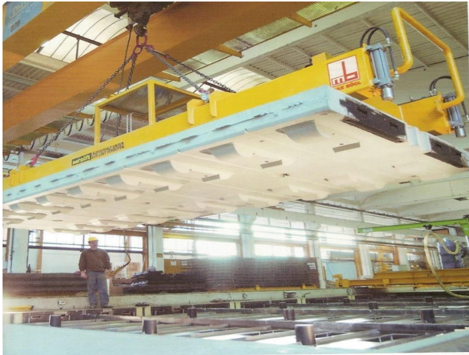
Рисунок 4.8 – Монтаж из формы бетонной плиты при заводском изготовлении
