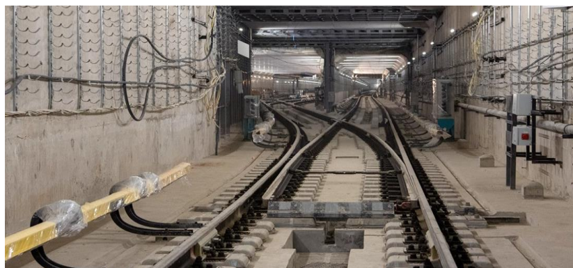
Рисунок 4.7 – Стрелочный перевод на би-блочных полушпалках
