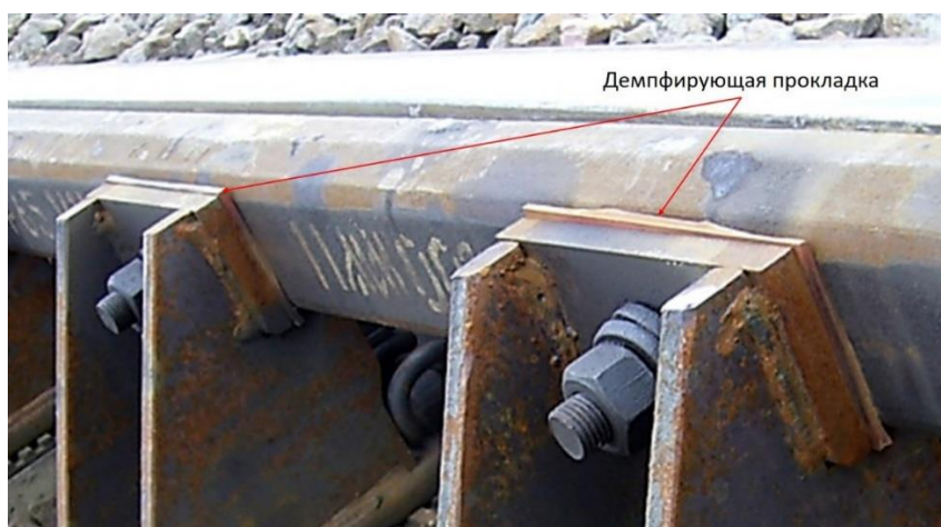
Рисунок 6.2 - Демпфирующие прокладки, установленные на контррельсовом узле
