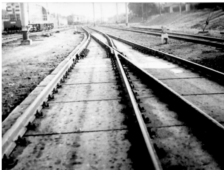
Рисунок 4.14 – Вид стрелочного перевода со стороны его закрестовинной части
