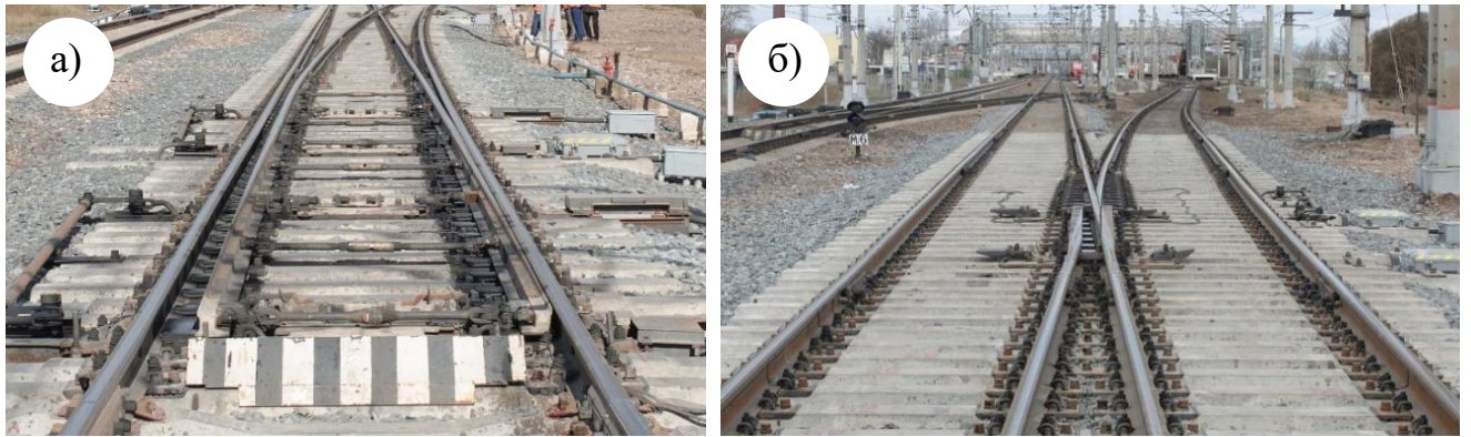
Рисунок 4.2 – Стрелочный перевод типа Р65 марки 1/22 АО «НСЗ» (проект Н03.002) собственная разработка Новосибирского стрелочного завода: а) стрелка перевода, оборудованная двумя комплектами гарнитур электроприводов с внешними замыкателями; б) крестовина марки 1/22 перевода, оборудованная двумя комплектами гарнитур электроприводов с внешними замыкателями
