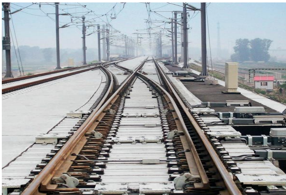
Рисунок 4.11 – Стрелочный перевод на бетонных плитах заводского изготовления
